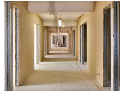
Lehm-Dünnlagen Beschichtung beim BV UN-Campus, Bonn
