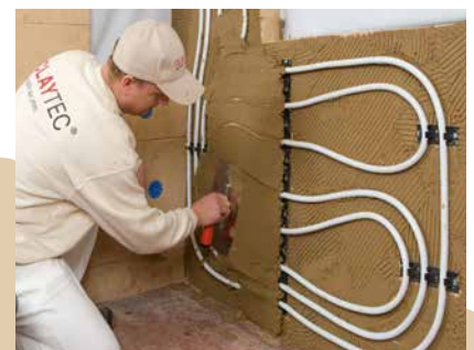
Der Unterputz wird über die Rohrscheitel abgezogen
